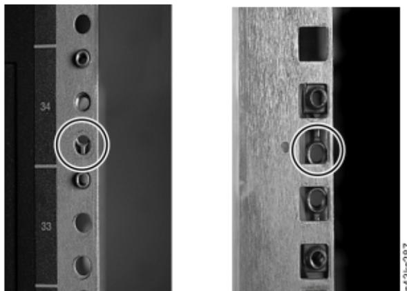
Figure 36. Emplacements de connecteur incorrects
